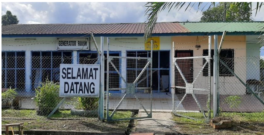
Gambar 5 menunjukkan ruangan yang menempatkan genset sekolah.
